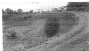
Foto 47: Aterro sanitário - nova célula em implantação e portaria.
