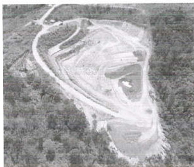
Foto 9: Vista geral do aterro sanitário.
