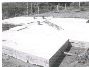
Foto 10: Aterro sanitário - caixa de coleta de percolato.
