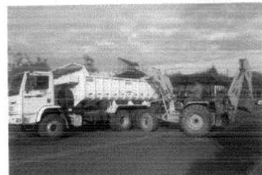
Foto 27: Coleta de lançamento irregular de lixo em estrada municipal.
